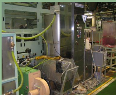
廃液処理設備(一次処理)
